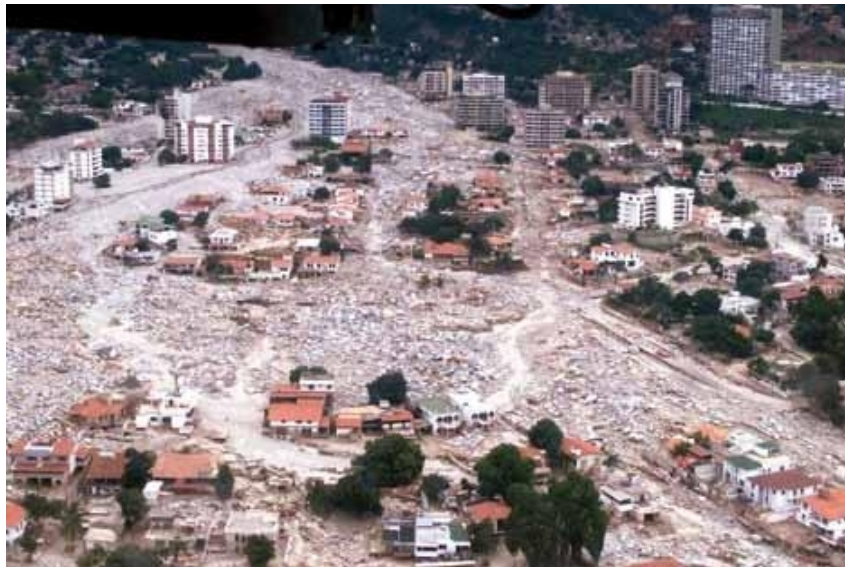
Figura 13 - Danos causados por um fluxo de detritos na cidade de Caraballeda.
