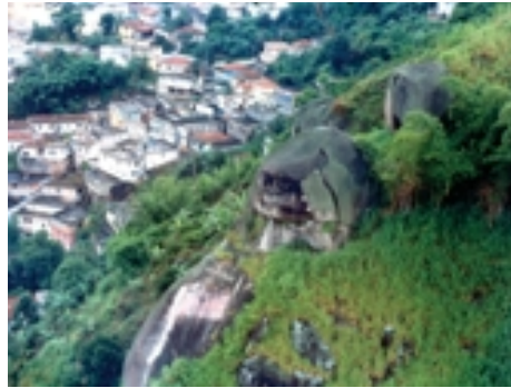
Figura 8 – Área de risco de processos de queda de blocos rochosos.
