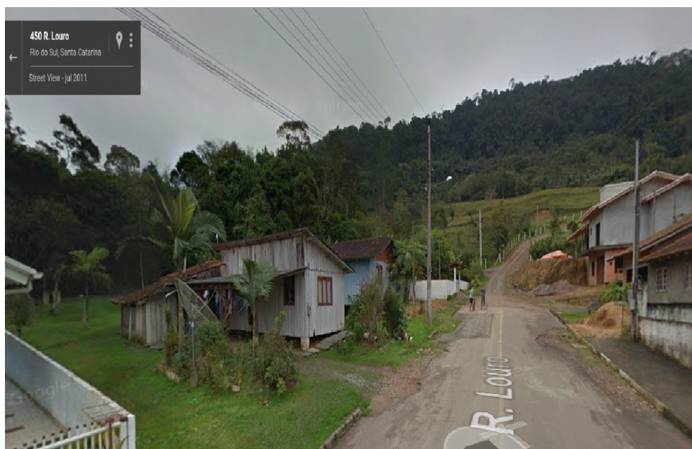
Figura 1 – Vista da Rua Louro antes do movimento de massa.
