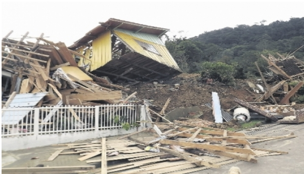
Figura 2 – Vista da Rua Louro após o movimento de massa.
