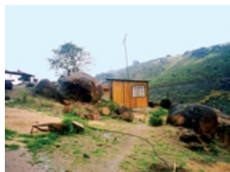
Figura 11 – Situação de risco de rolamento de bloco rochoso.
