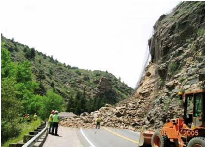
Figura 7 - Queda rochosa e detritos ocorrido em Clear Creek Canyon, Colorado, EUA, em 2005.
