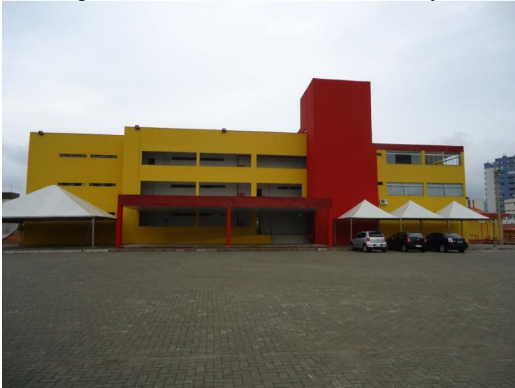
Figura 4: Pavilhão de salas de aula e coordenação
