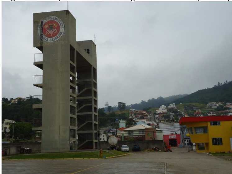
Figura 6: Torre para treinamentos e guarita de entrada (à direita)
