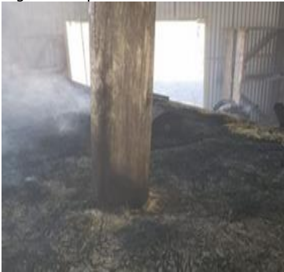
Figura 12 – Marca de combustão vertical na geratriz oposta a incidência do vento.
