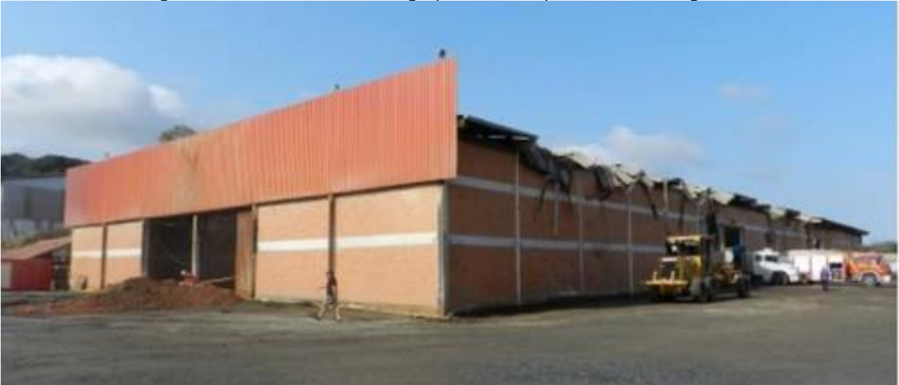
Figura 01 – Vista aérea dos galpões da empresa Global Logística.
