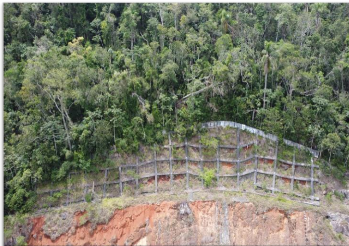
Figura 5: Grelha atirantada para contenção do talude.
