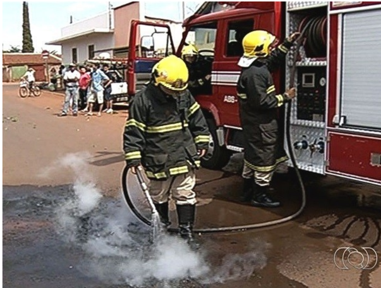
Figura 9- Água ferve em contato com asfalto danificado por fio de alta tensão
