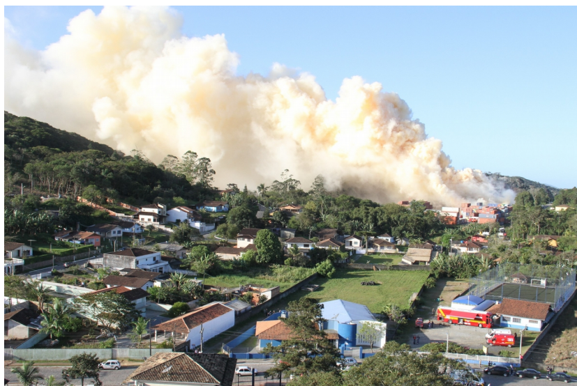
Figura 14 - Distância entre o APC-01 e o galpão da Global Logística (fotografia)
