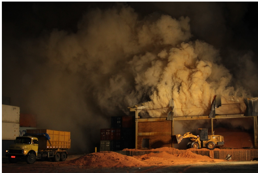
Figura 19 - Máquinas trabalhando na retirada do fertilizante de dentro do galpão
