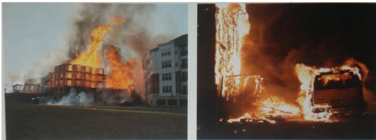
Figura 9: Prédio adjacente e veículo entram em ignição pela radiação térmica
