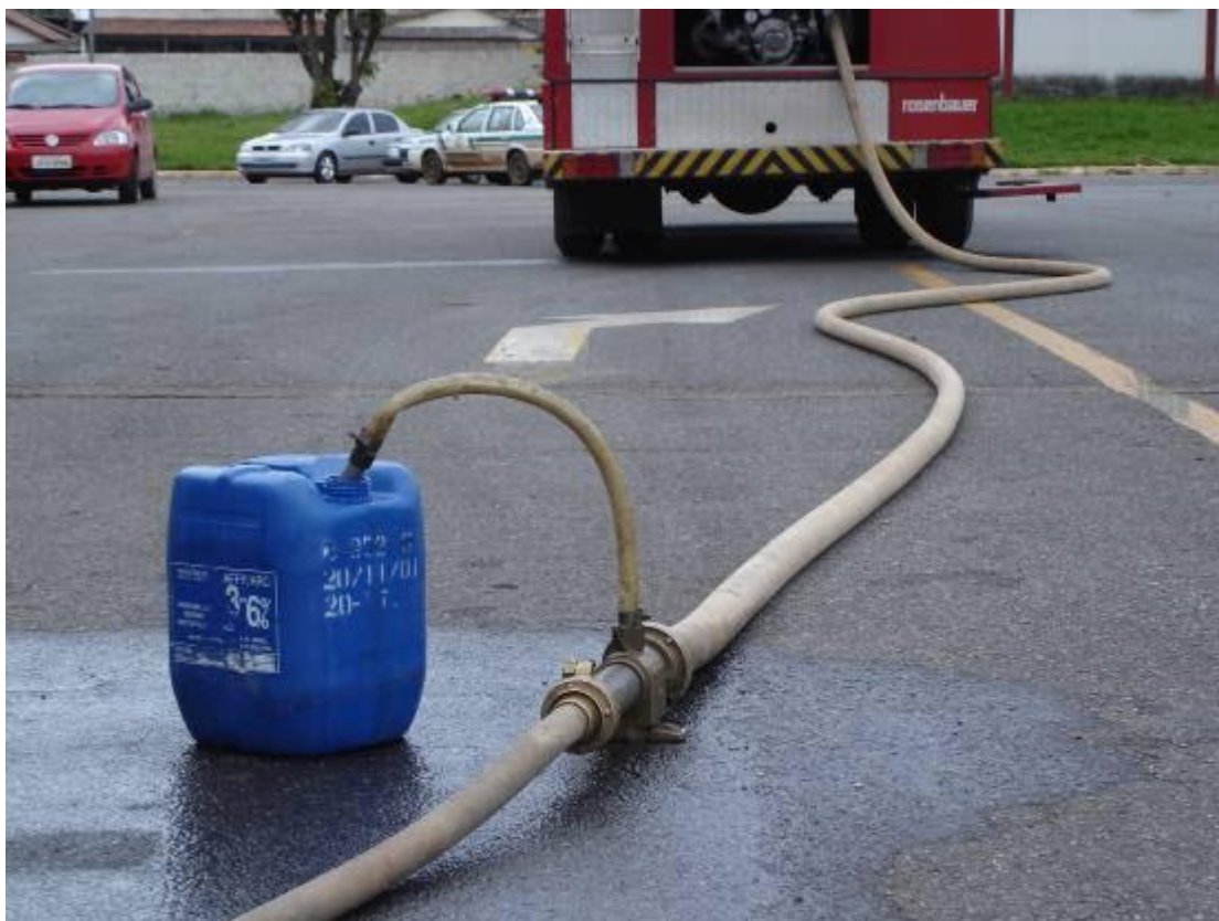
Figura 18 - Proporcionador instalado entre duas linhas de mangueiras
