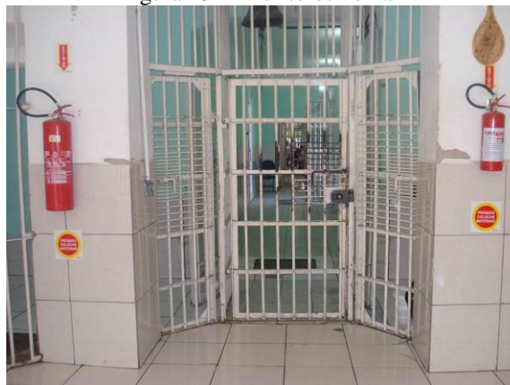
Figura 15 – Extintores no hall
