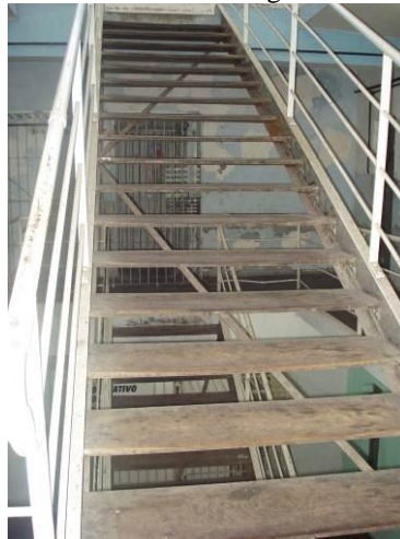
Figura 17 – Escadas com degraus em madeira
