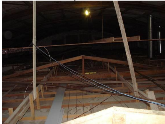
Figura 6 – Madeiramento do telhado, forro em PVC e fiação elétrica
