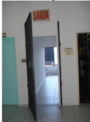
Figura 5 – Porta de saída do hall de acesso à carceragem
