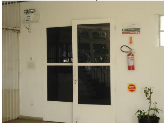
Figura 16 – Sistemas preventivos no prédio da administração
