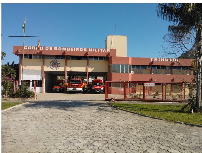
Figura 4 - Fachada da 3ª Companhia do 1º Batalhão de Bombeiro Militar
