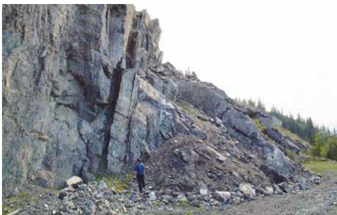
Figura 8- Bloco rochoso envergando.
