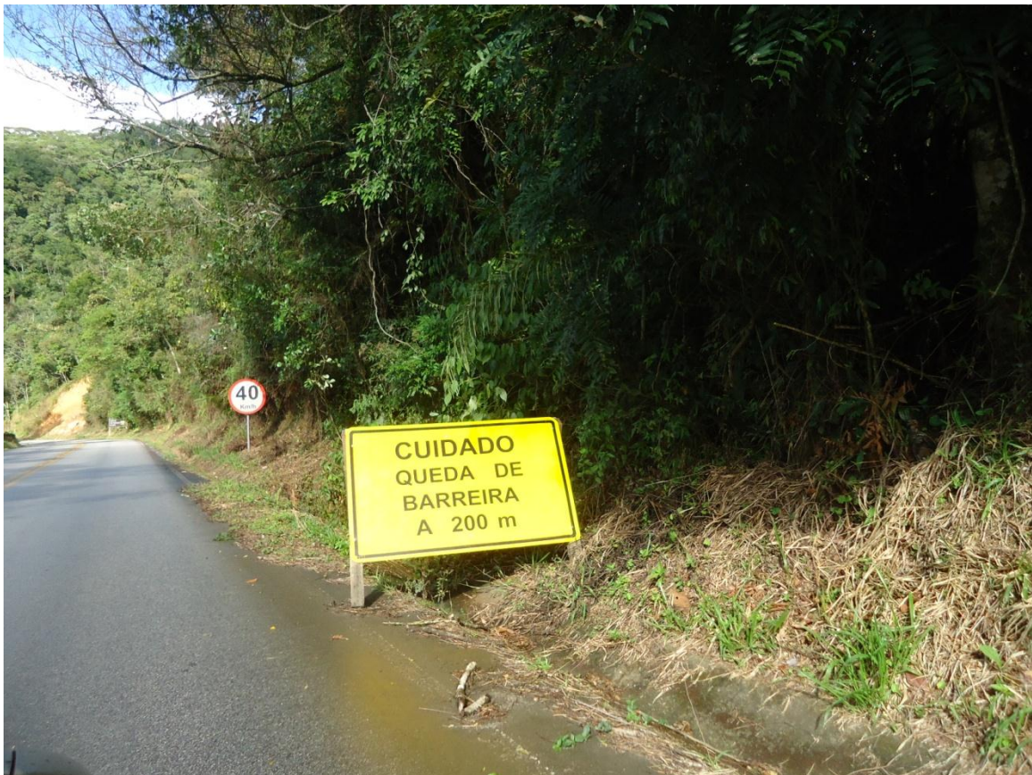
Deslizamentos de terra na SC 431 Águas Mornas SC
