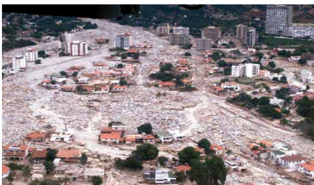
Figura 18- Danos causados por um fluxo de detritos.
