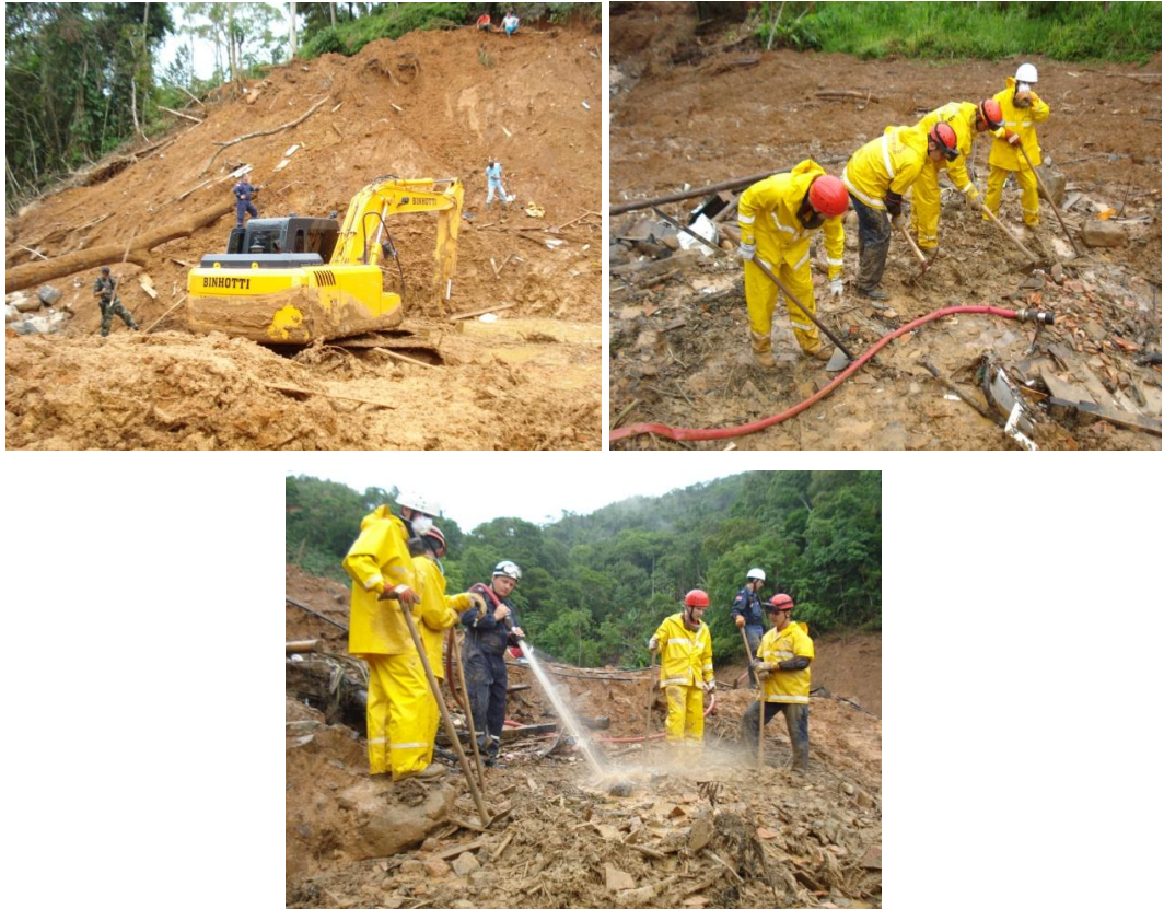
Figura 36- Técnicas de escavação em áreas deslizadas, Morro do Baú Ilhota – SC.
