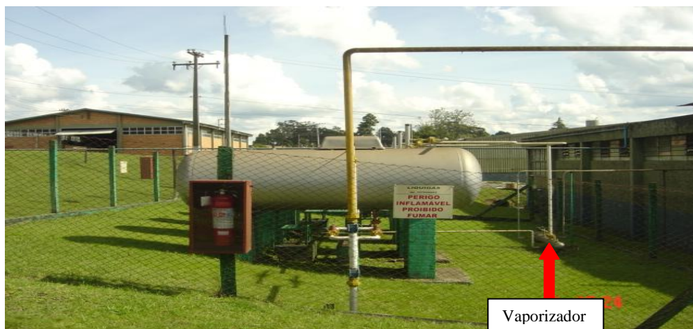
Figura 10 - Instalação do vaporizador Empresa Minusa Trator Peças LTDA
