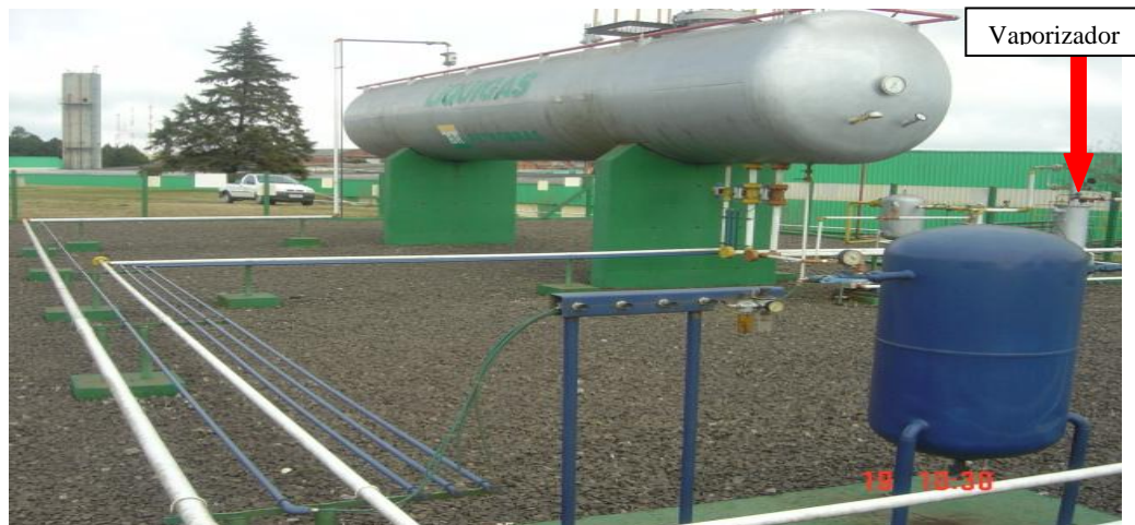
Figura 9 - Instalação do vaporizador Empresa Klabin Lages
