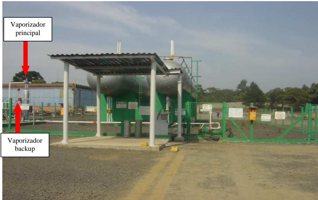
Figura 8 - Instalação dos vaporizadores Empresa Kimberly Clark Brasil
