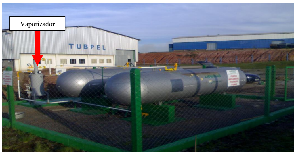
Figura 11 - Instalação do vaporizador Empresa Tubpel
