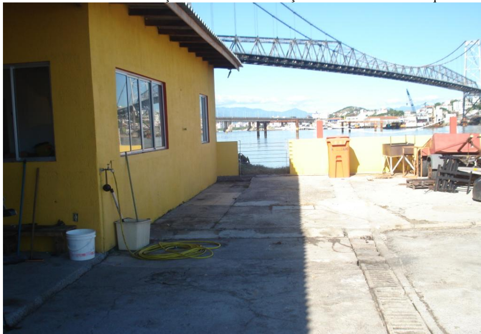
Figura 10: Local destinado a realização da atividade de lavagem externa de viaturas no quartel do GBS
