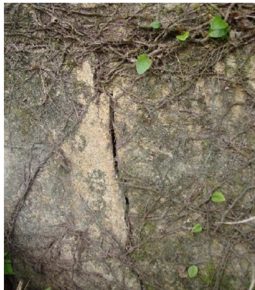
Figura 28 - Rachadura em Rocha da área de estudo
