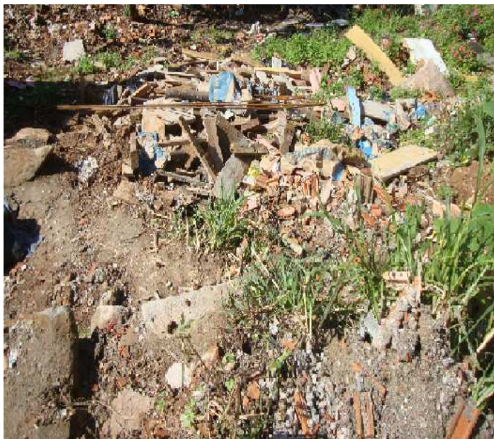
Figura 21 - Acúmulo de lixo em encosta Morro do Horácio
