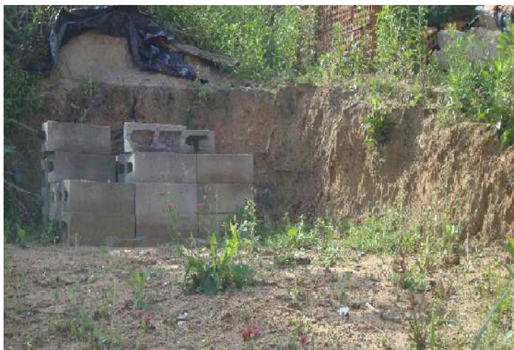
Figura 19 - Corte realizado na encosta para construção
