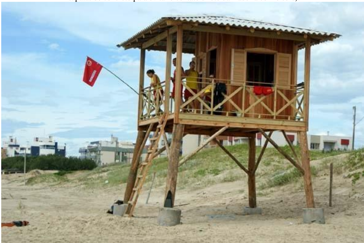
Figura 23: Posto de salvamento construído em madeira na praia do Rincão na cidade de Içara (nota-se o uso de sapatas de concreto para evitar o contato direto da madeira com o solo).
