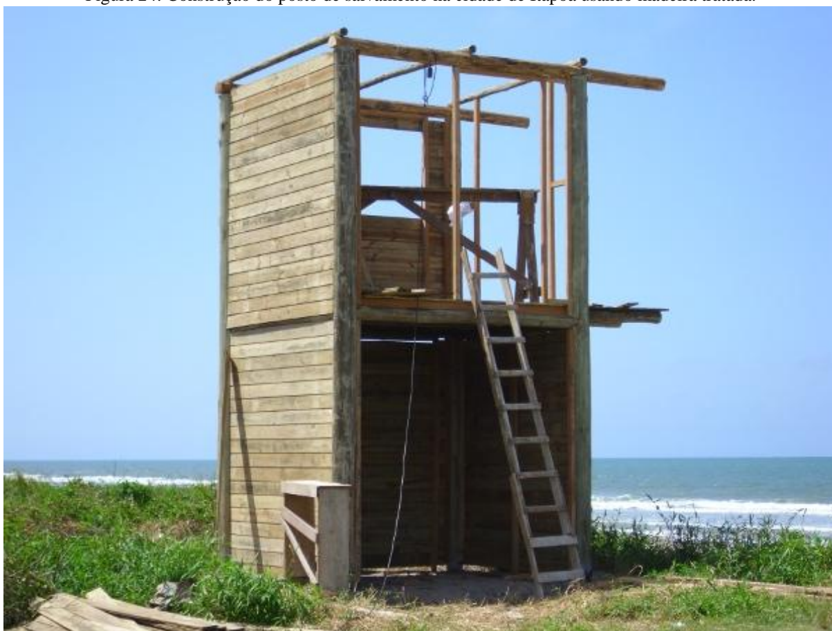
Figura 24: Construção do posto de salvamento na cidade de Itapoá usando madeira tratada.
