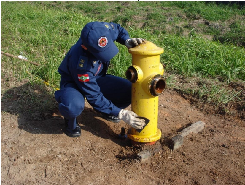
Foto 33 – Lixamento do hidrante e dos tampões.
