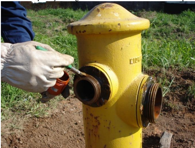
Foto 30 - Aplicação de graxa na rosca de conexão do tampão.
