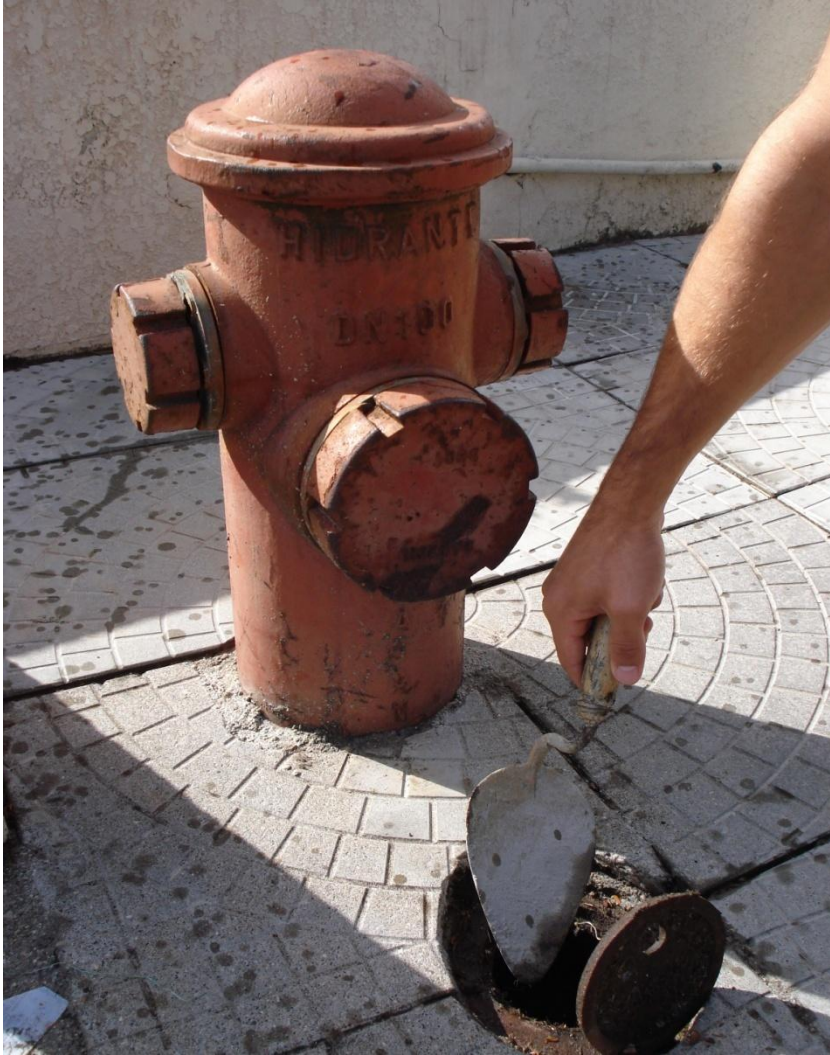
Foto 23 – Limpeza da caixa do registro.
