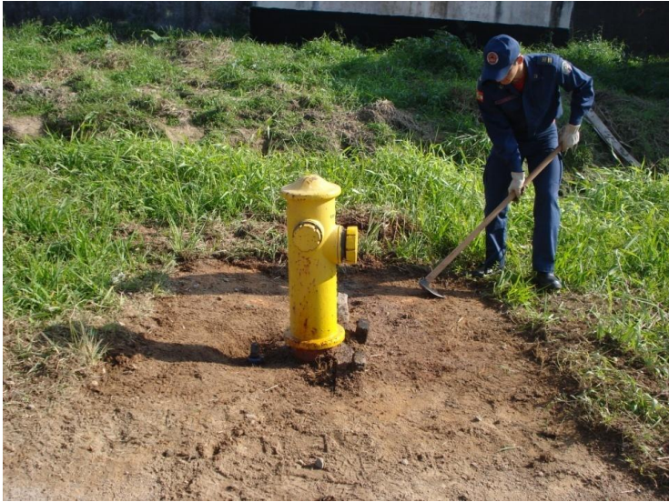
Foto 29 – Final da limpeza.
