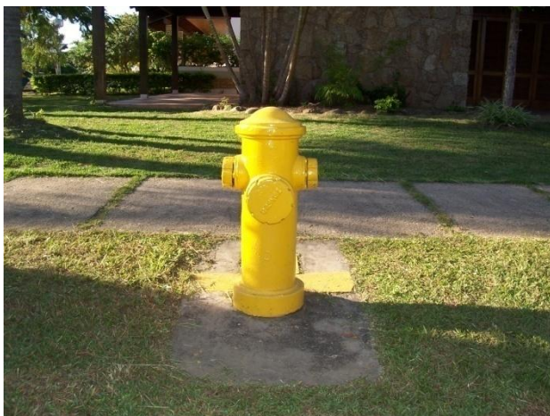
Foto 19 - Hidrante de coluna.
