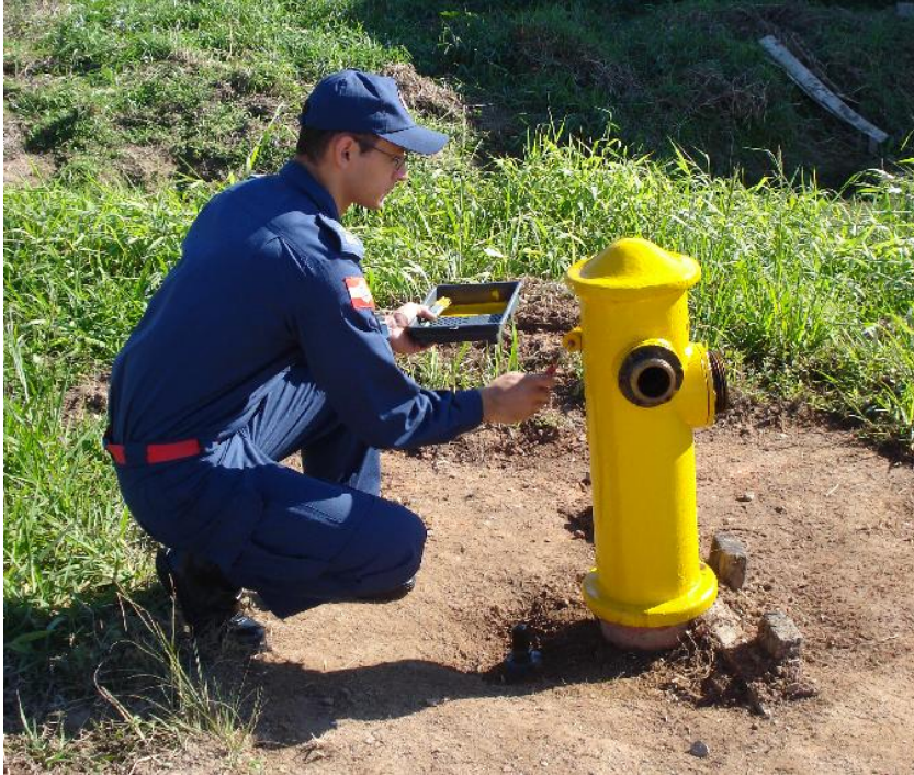
Foto 34 – Pintura do corpo do hidrante com rolo.
