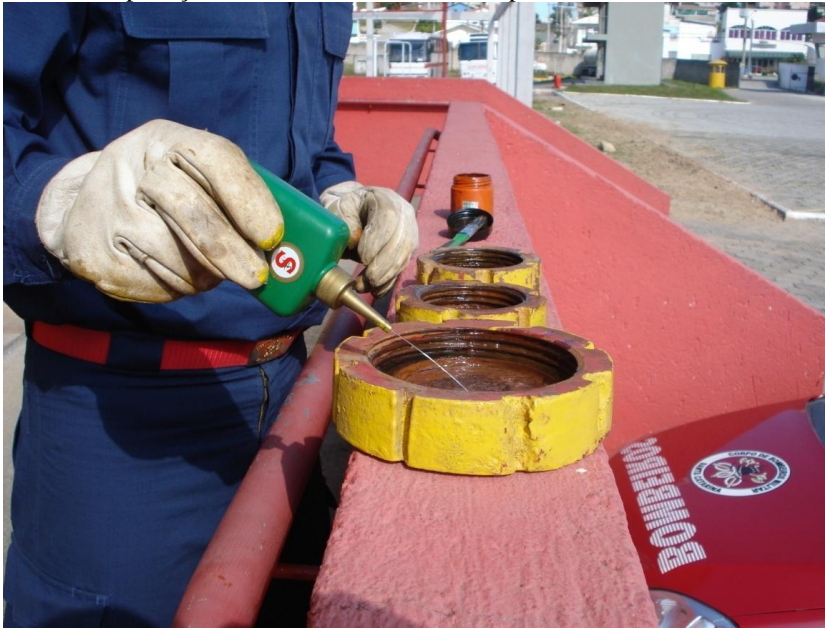
Foto 31 - Aplicação de óleo lubrificante no tampão.
