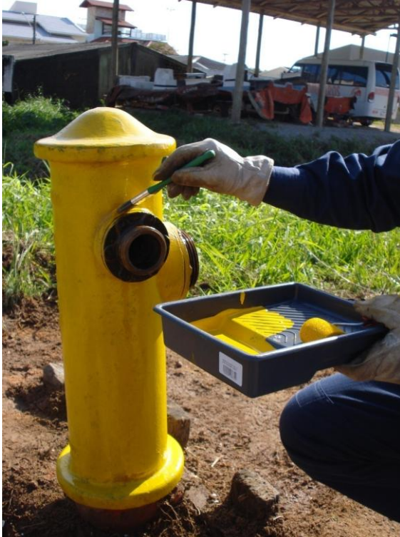
Foto 35 – Retoque da pintura com pincel.
