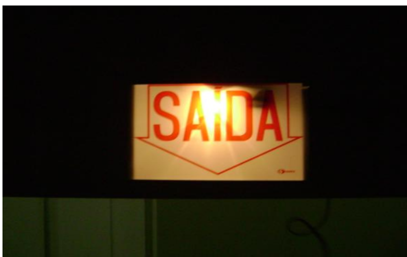
Foto 2 – Tipos de Bloco Autônomo em uso numa situação de falta de luminosidade.
