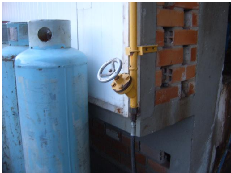
Foto 14 – Detalhe da conexão da mangueira à extremidade da tubulação
