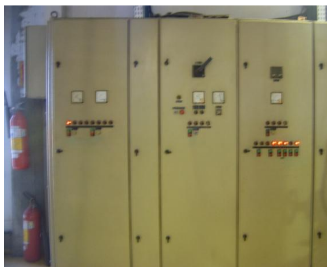
Foto 28 – Vista dos fundos da sala de máquinas
