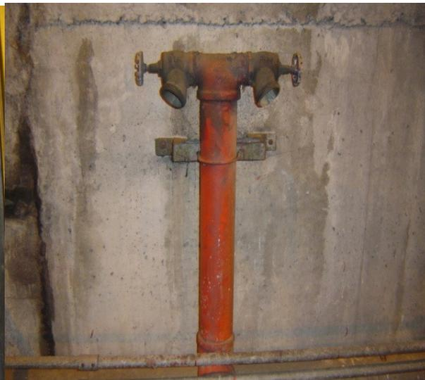
Figura 16 – Hidrante de Coluna
