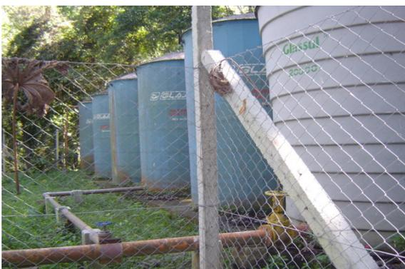
Figura 13 – Reserva Técnica de Incêndio Túnel Morro do Boi
