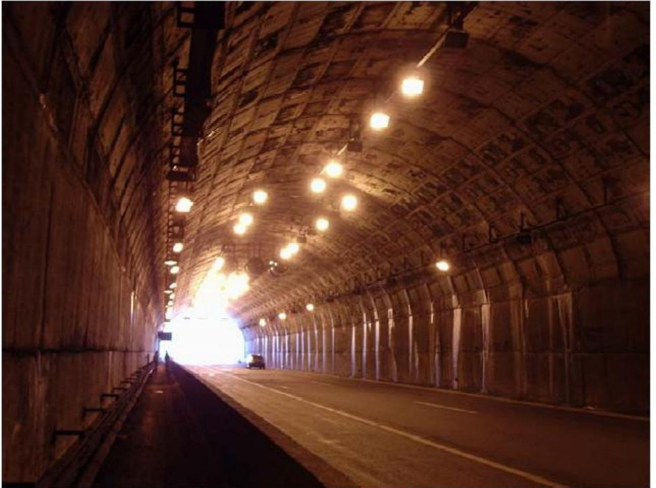
Interior do emboque sul, no sentido contrário ao tráfego, onde pode-se ver a diferença de iluminação, para permitir a adaptação do olho do motorista
