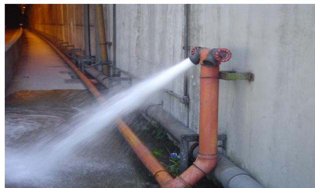
Figura 14 – Hidrante de Coluna: Túnel Morro do Boi
