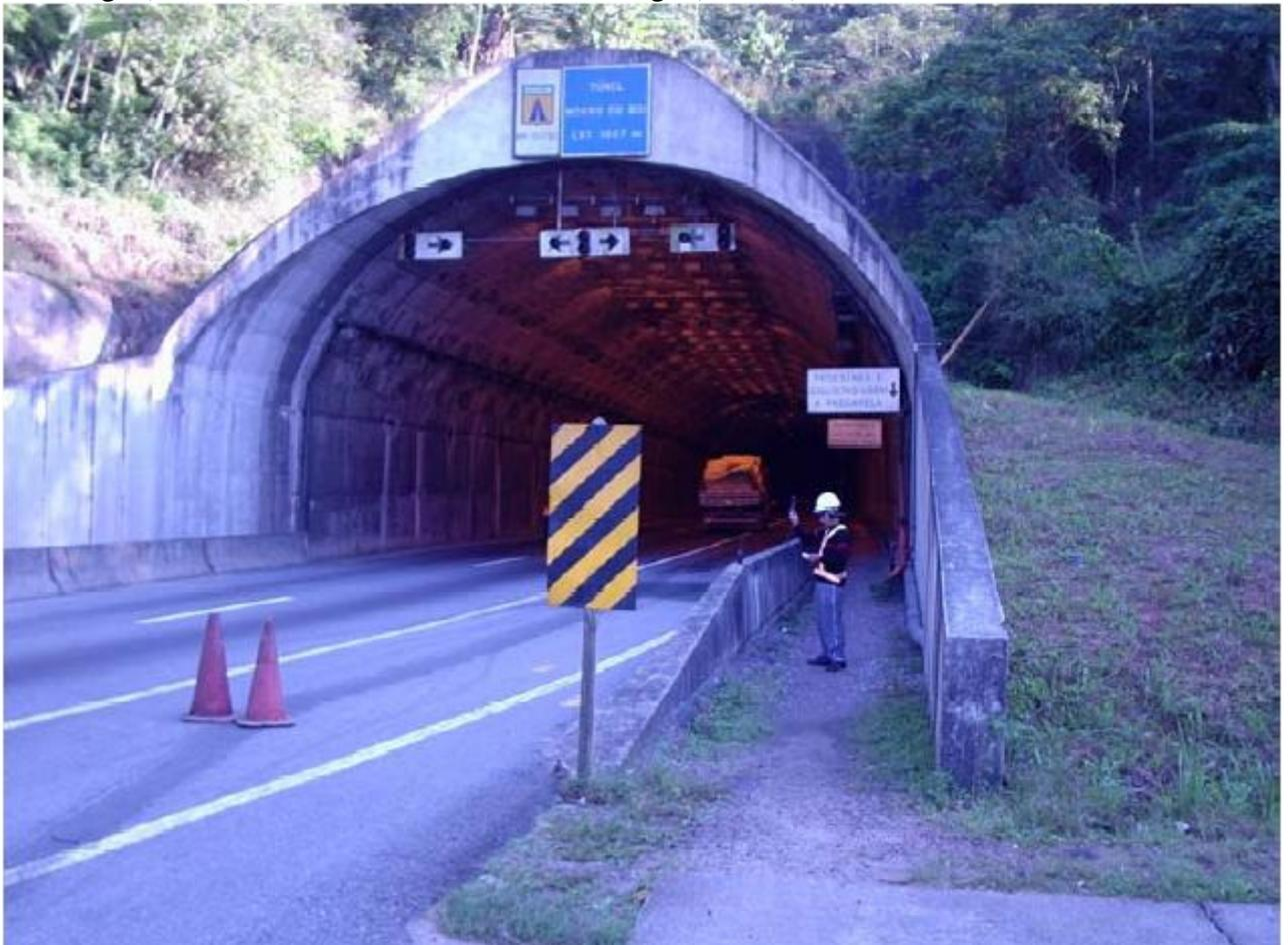
Emboque Sul do Túnel, onde se pode ver os semáforos na entrada e o monitor fazendo a verificação da velocidade do vento, com o anemômetro.
