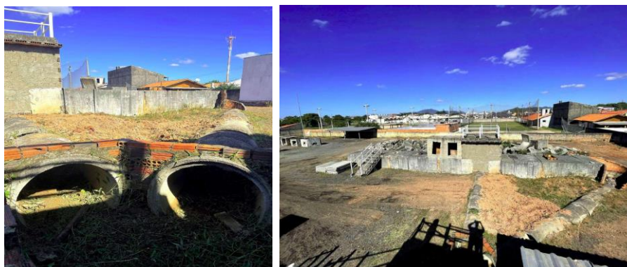
Figura 7 - Pista de Brec e Vista geral da pista
