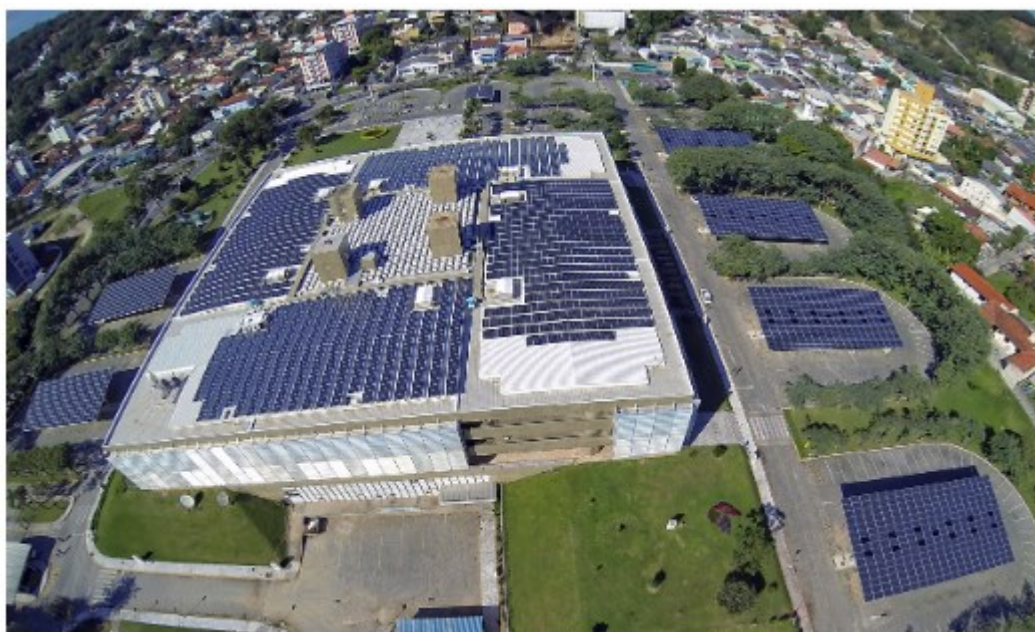
Figura 4 – Usina solar Megawatt no edifício sede da Eletrosul em Florianópolis-SC, com painéis integrados na cobertura do prédio e estacionamentos
