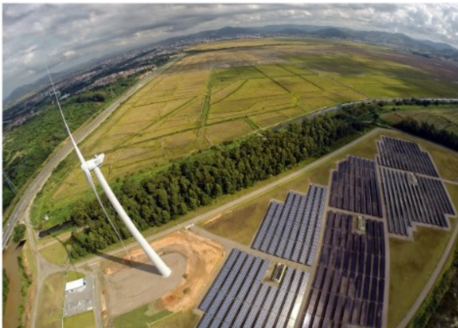
Figura 5 – Usina de energia Cidade Azul localizada no município de Tubarão, pertencente a Tractebel Energia
