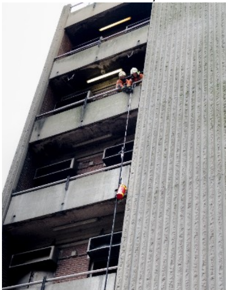
Figura 5 - Içamento de mangueira pela fachada da edificação.
