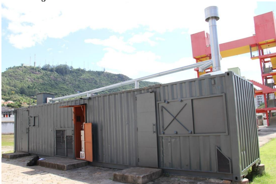
Fotografia 2 – Contêiner simulador de incêndio estrutural.
