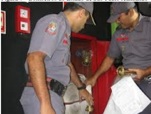
Figura 7 - Bombeiros do Estado de São Paulo realizando vistoria em SHP.
