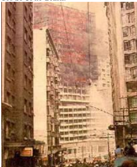
Figura 5 - Incêndio no Edifício Andraus em São Paulo/SP, desastre que marca o início da implantação normativa dos SPCI no Brasil.
