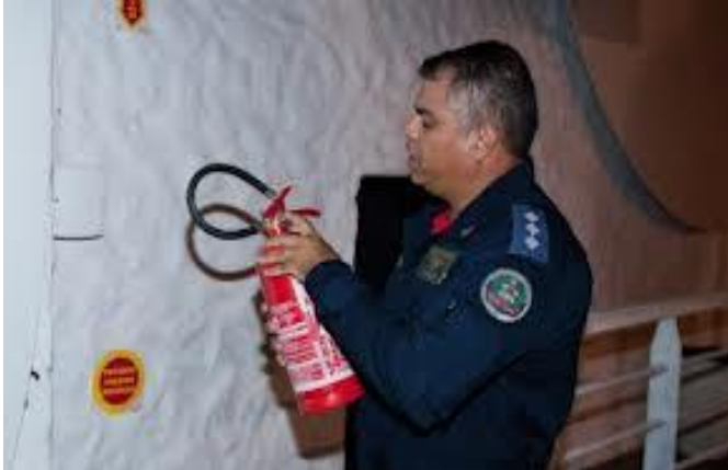
Figura 6 - Bombeiro catarinense vistoriando um Sistema Preventivo por Extintores (SPE).
