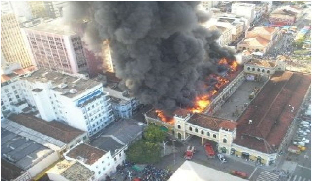
Fotografia 7 – Incêndio Mercado Público de Florianópolis
