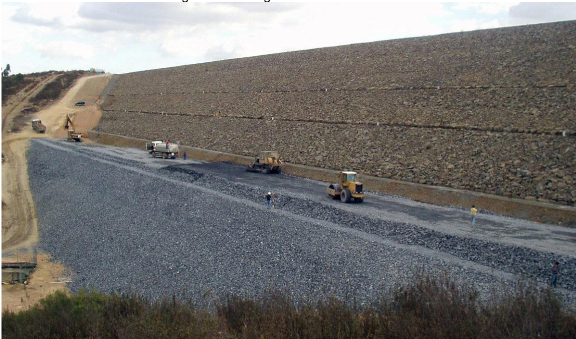
Figura 2 - Barragem de enrocamento
