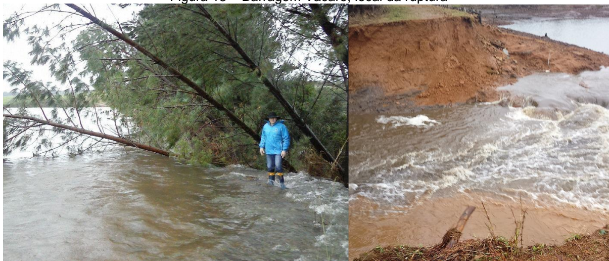
Figura 13 – Barragem Vacaro, local da ruptura
