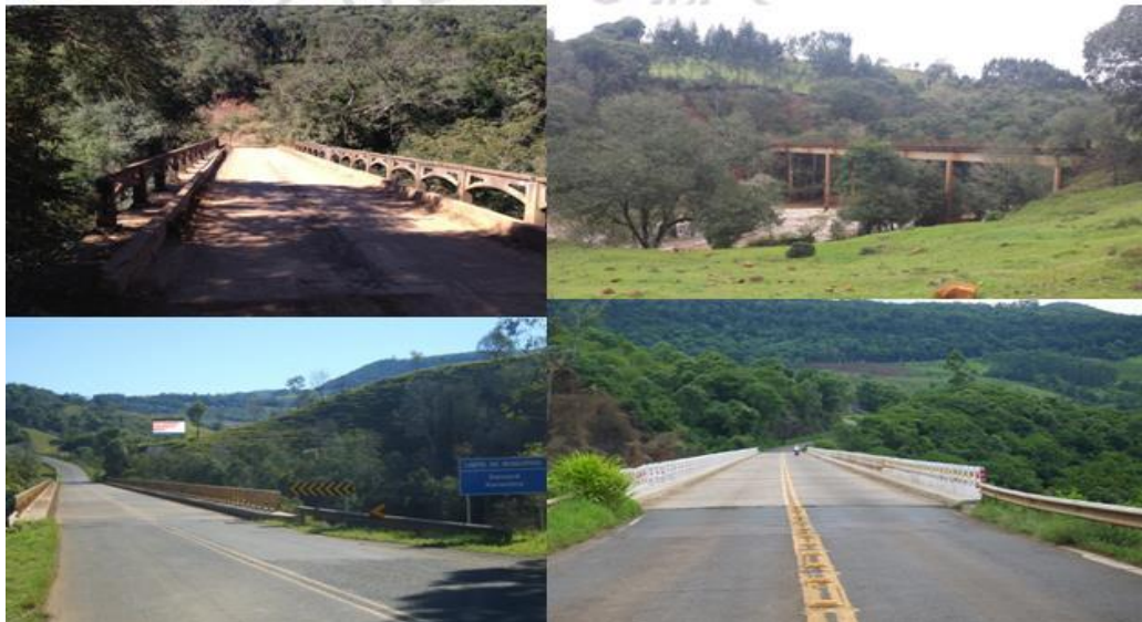
Figura 16 – Pontes a jusante do ponto de rompimento da Barragem Vacaro
