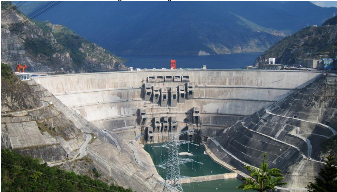
Figura 1 - Barragem de concreto
