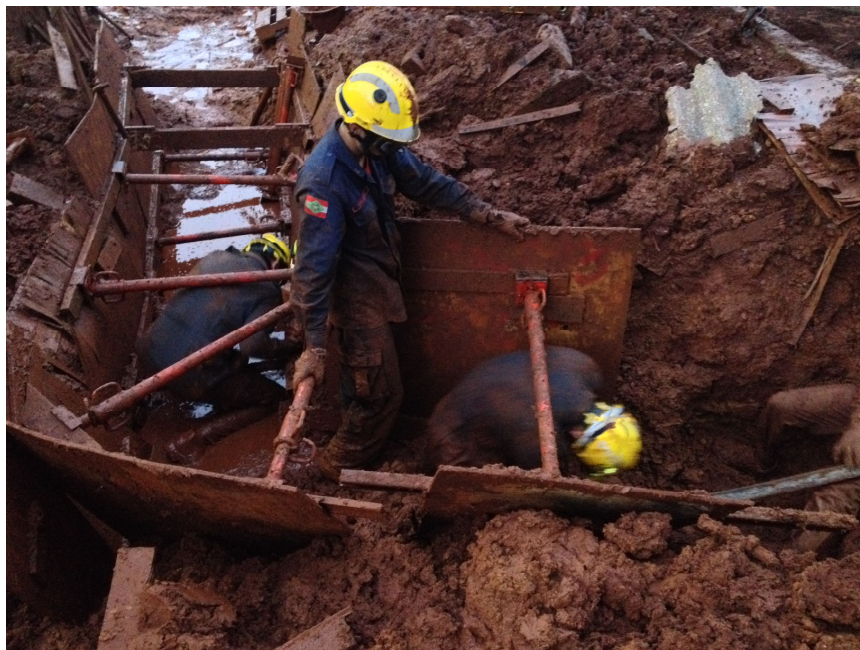
Figura 01 - Intervenção em áreas deslizadas
