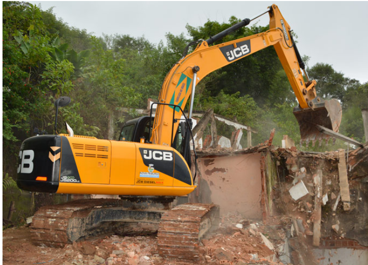
Figura 6 : Demolição de casas em áreas de risco
